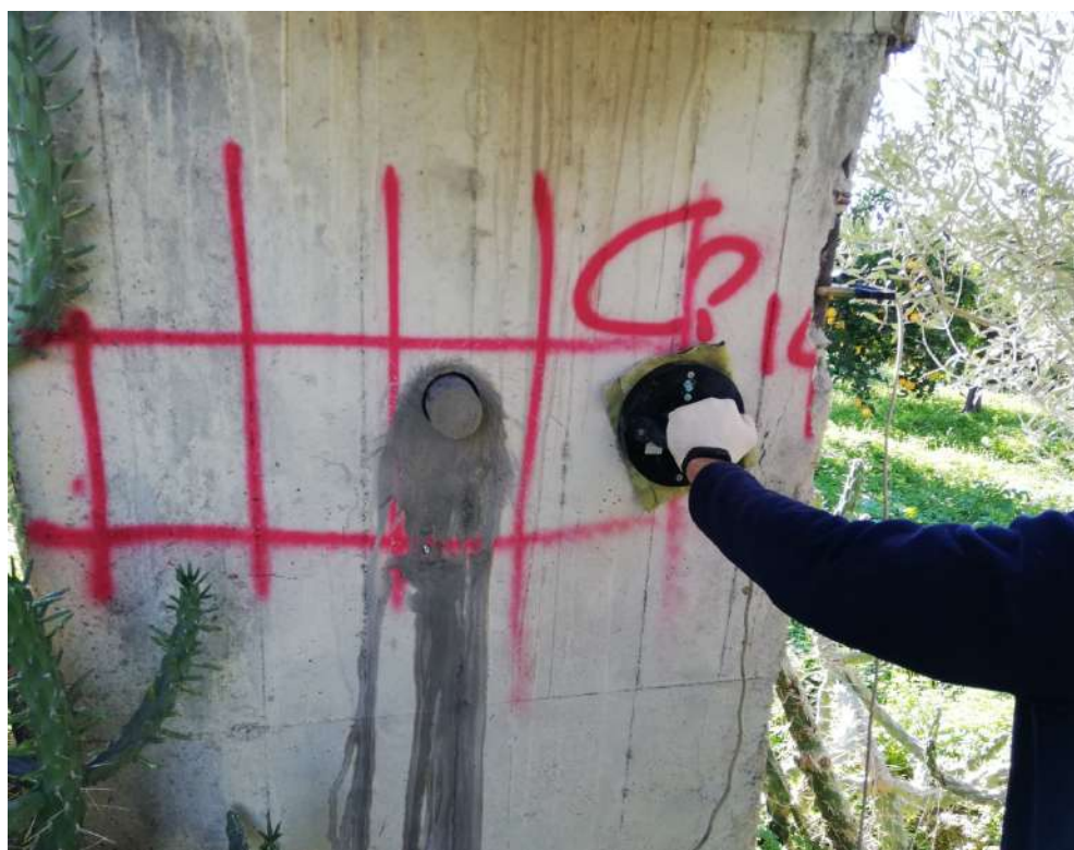
- Mappatura di barre e del potenziale (Half-cell) e della velocità di corrosione (GECOR).
