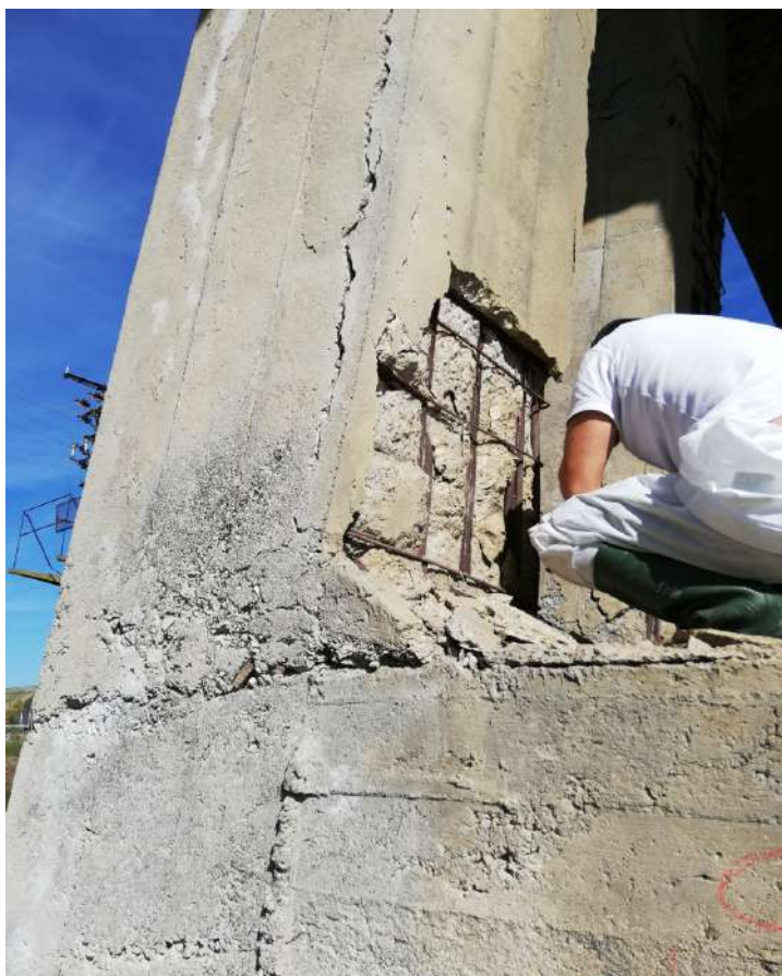
- Prelievo di barre d'armatura.
