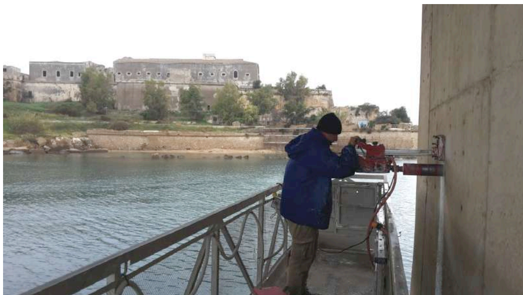
- Prelievo di calcestruzzo, mediante carotaggio.
