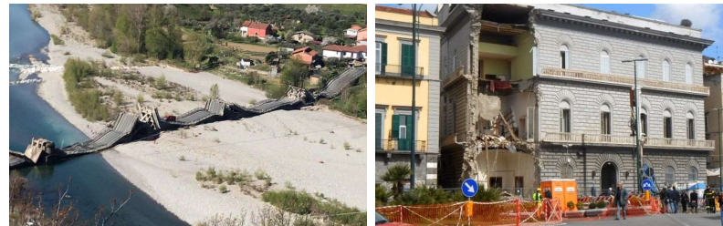
Crollo Ponte ad Aulla - 2020
